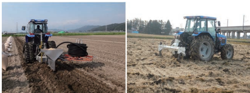
図2 排水対策技術（左：浅層暗渠施工、右：補助暗渠をサブソイラにより施工） 左の写真は農研機構東北農業研究センター冠秀昭氏より提供
