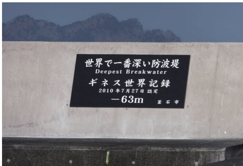
湾口防波堤ギネスプレート
