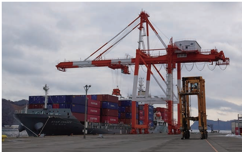
ガントリークレーン
